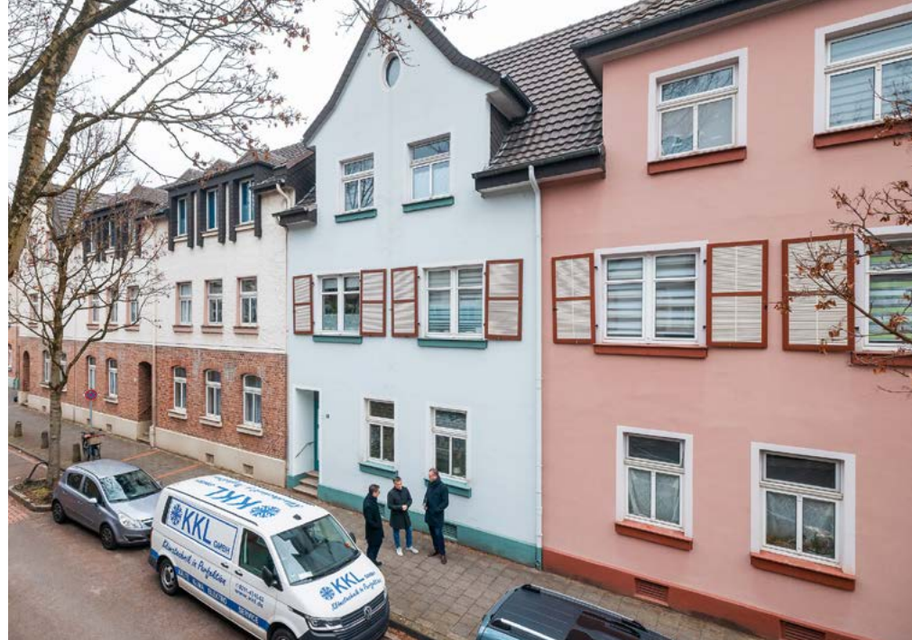
Die Kolpingsiedlung in Neuss gilt als Zeugnis des genossenschaftlichen Arbeiterwohnbaus zu Beginn des 20. Jahrhunderts
